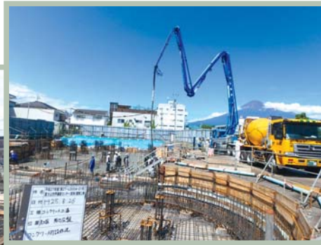
基礎梁のコンクリート打設が終わり、1階床の鉄筋を設置しています。
