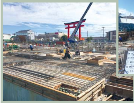
耐圧盤（基礎底盤）のコンクリートを打設しています。
