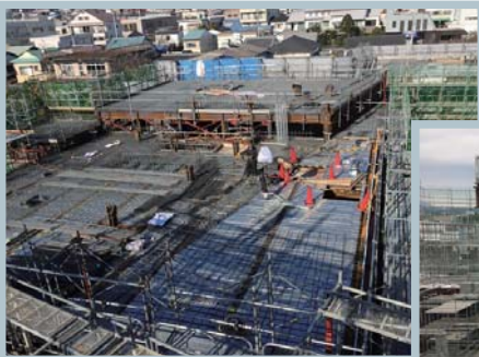
西棟屋上のコンクリート打設前写真
